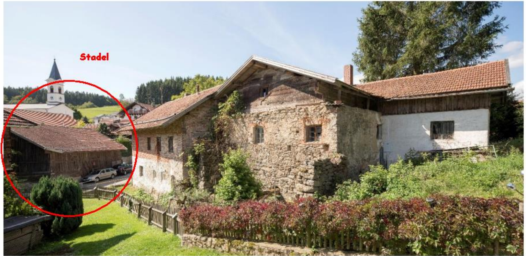
Mühlengebäude Ansicht von Nordosten
