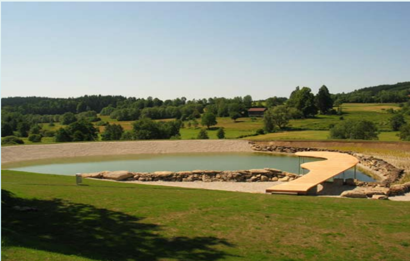
Frühsommer 2004: Kurz vor der Fertigstellung
