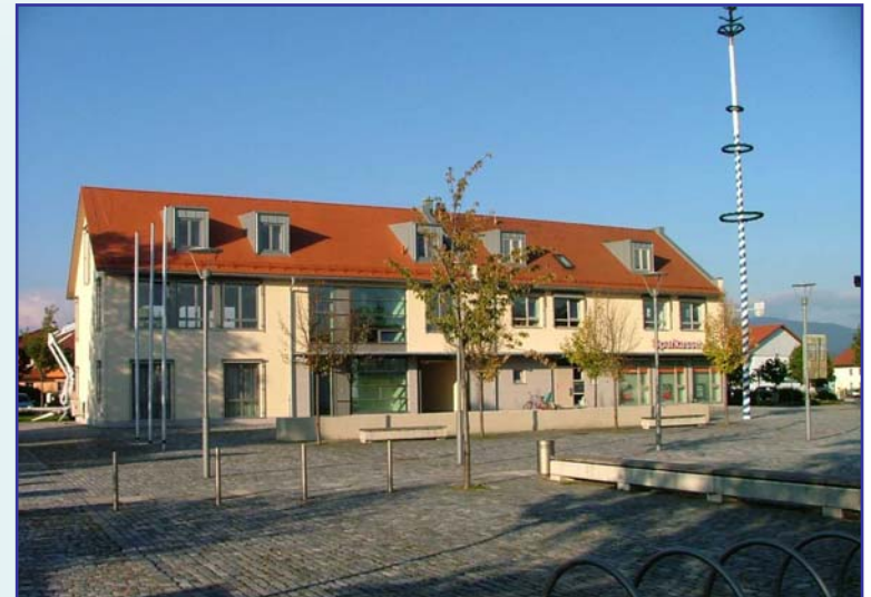
Außenansicht nach Fertigstellung
